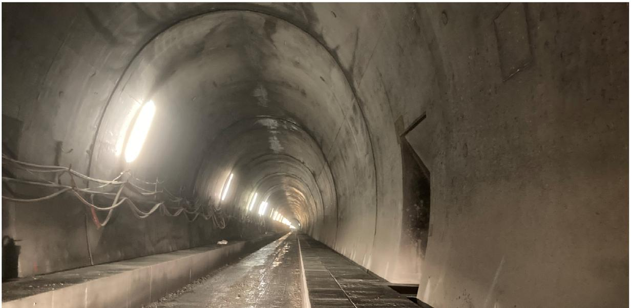
*Neuer Albulatunnel im Rohbau; Ortbetongewölbe, Sohle und beidseitige Bankette mit Kabelrohranlagen*
