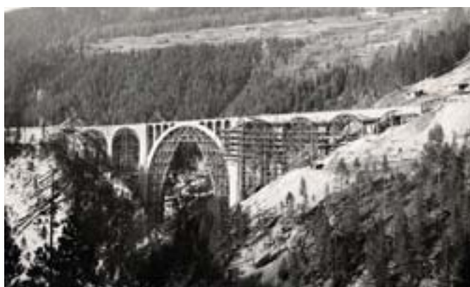
Strecke Davos–Filisur > Wiesnerviadukt. Das imposante Lehrgerüst stammt vom legendären Gerüstebauer Richard Coray. Aufnahme 1908. Rhätische Bahn
