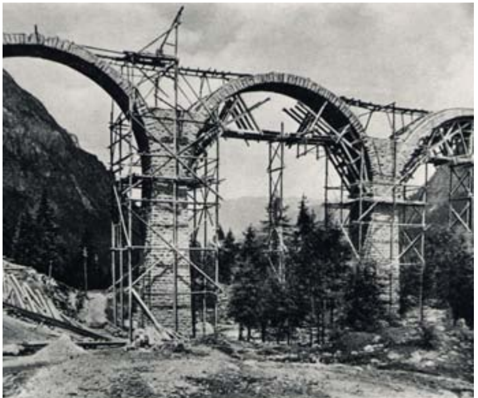
Albulastrecke > Der Albulaviadukt III ⑥ im Bau, 1902. Rhätische Bahn
