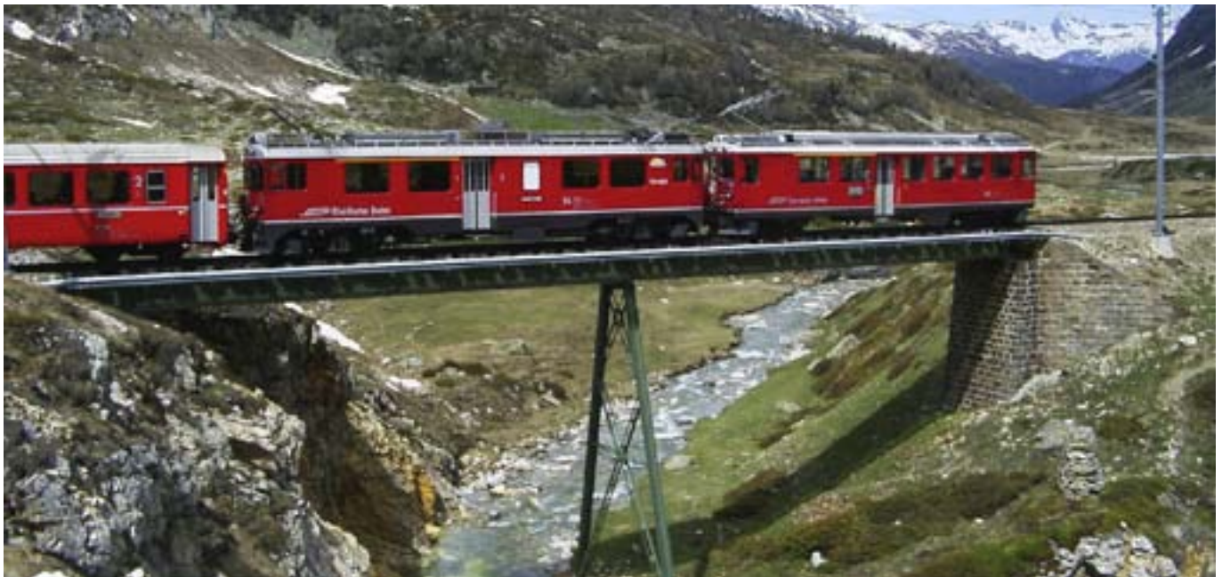
Berninastrecke > Die Untere Berninabachbrücke entstand 1934 im Zusammenhang mit einer Streckenänderung oberhalb der Alp Bondo. Rhätische Bahn
