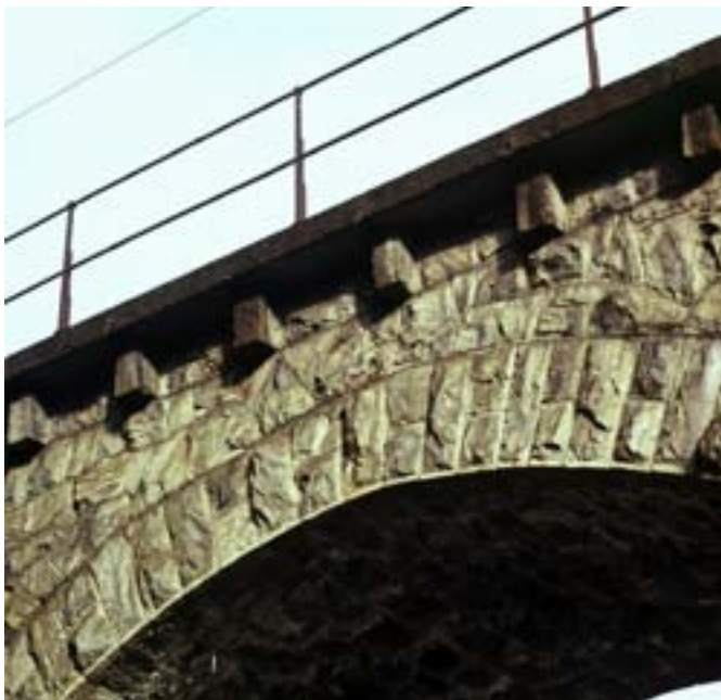
Solisviadukt > Detail der Mauerkrone und des Geländers. J. Conzett
