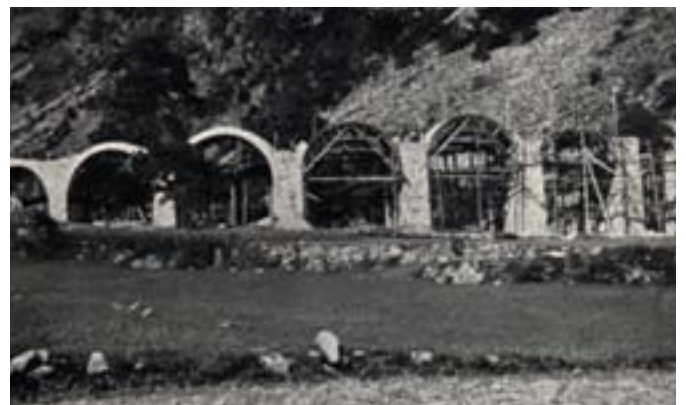
Kreisviadukt bei Brusio > Mauerung der Bögen, 1907. Foto aus E. BOSSHARD: Die Berninabahn , Zürich 1912 (Schweizerischen Bauzeitung, Sonderdruck).
