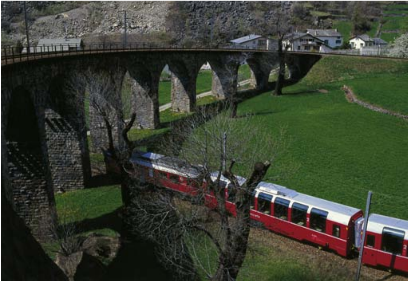
Berninastrecke > Der Bernina Express auf dem Kreisviadukt von Brusio, bei dem analog zu einem Kehrtunnel ein Höhen-sprung überwunden wird. P. Donatsch
