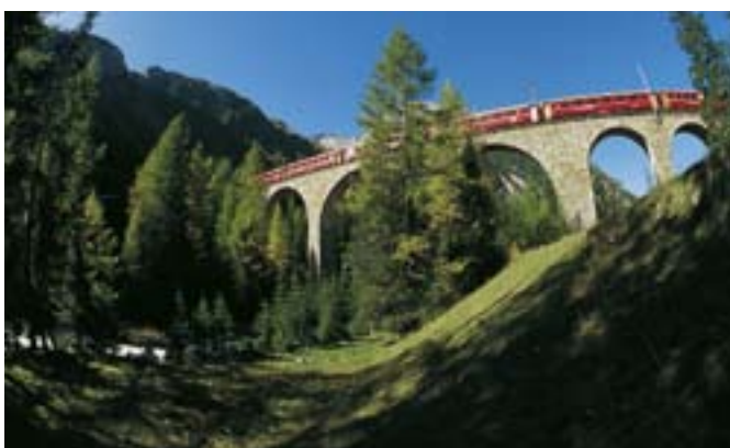
Albulastrecke > Der Albulaviadukt III, die Brücke mit der zweitgrössten Kubatur der Albulastrecke. Foto Geiger
