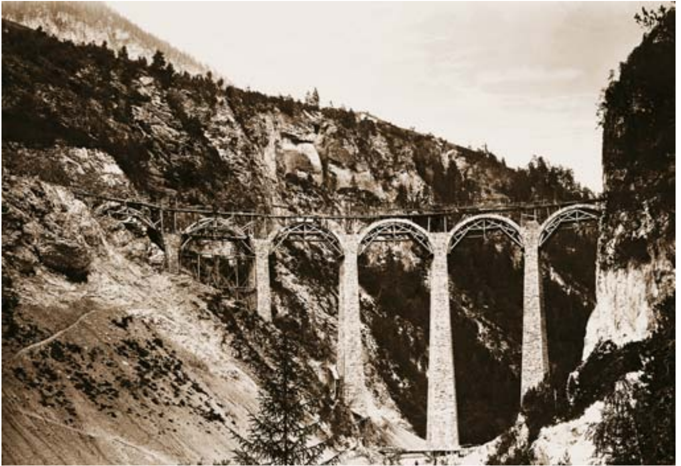
Albulastrecke > Landwasserviadukt bei Filisur im Bau, 1902. Rhätische Bahn
