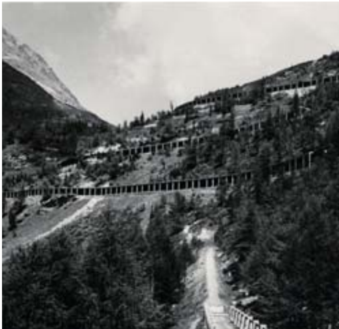
Berninastrecke > Die drei Traversierungen des Hangs der Alp Grüm sind mit Galerien gegen Lawinen geschützt. Aufnahme nach 1951. Rhätische Bahn
