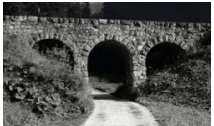
Albulastrecke > Dreibogige Überführung bei Bergün. J. Conzett
