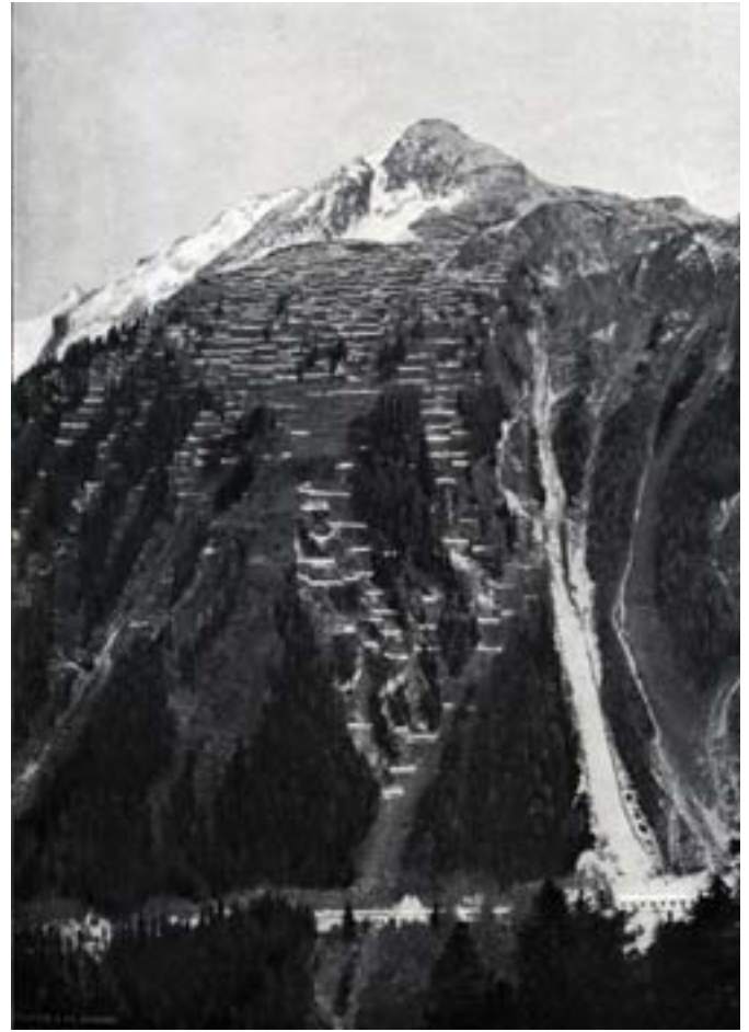
Albulastrecke > Die damals grösste Lawinerverbauung der Schweiz: Muot. Rechts unten die Chanaletta-Galerie, 1907. Rhätische Bahn
