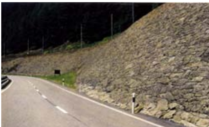
Berninastrecke > Unterhalb Miralago sind ausgedehnte Böschungssicherungen aus Trockenmauerwerk zwischen Bahn und Strasse zu sehen, die in ihrer Art und Grösse für Graubünden einmalig sind. J. Conzett
