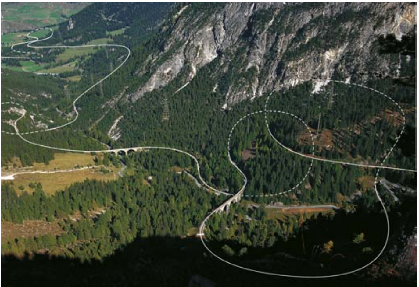
Albulastrecke > Künstliche Längenentwicklung zwischen Bergün/Bravuogn und Preda mittels Viadukten und Kehrtunnel. Gut sichtbar sind die Albulaviadukte II (links) und III (rechts). Foto Geiger
