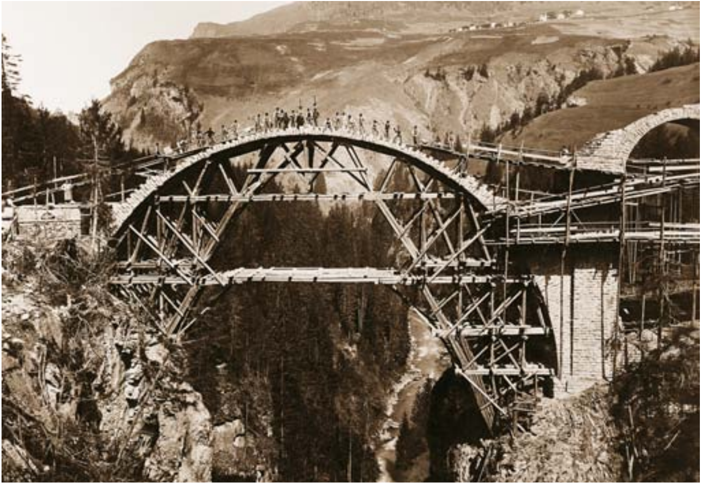
Albulastrecke > Der 42 m weit gespannte Solisviadukt im Bau. Rhätische Bahn
