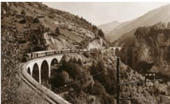
Albulastrecke > Historische Aufnahme mit Schmittentobel- und Landwasserviadukt. Rhätische Bahn
