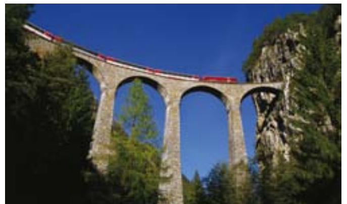
Filisur > Auch über 100 Jahre nach seiner Erbauung ist der Landwasserviadukt im ursprünglichen Zustand erhalten. Canal, Engadin Press
