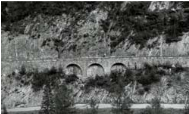
Albulastrecke > Dreibogenmotiv in der Stützmauer bei Fuegna ❶, die beim Austritt aus dem Rognux-Tunnel für die Bahnreisenden sichtbar wird. J. Conzett
