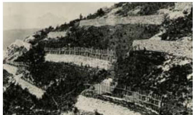
Albulastrecke > Mauern mit Schneerechen der Lawinerverbauung Muot. Rhätische Bahn
