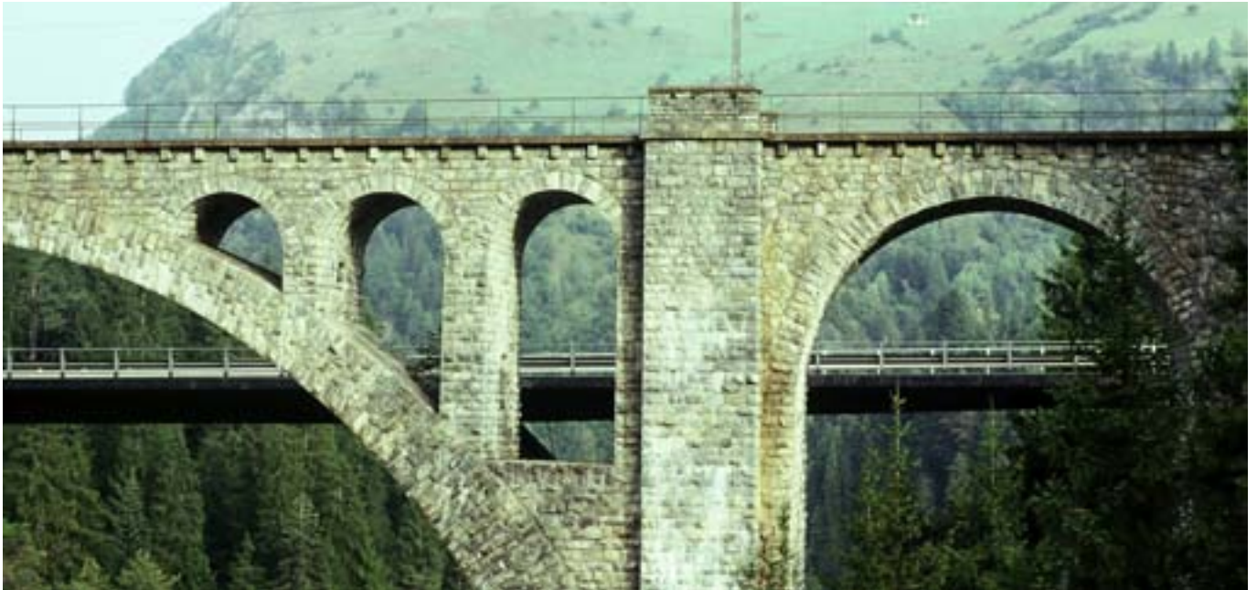
Albulastrecke > Beim Solisviadukt wurde ein vom Normtyp abweichendes Geländer ausgeführt, das in der Seitenansicht besonders filigran erscheint. J. Conzett
