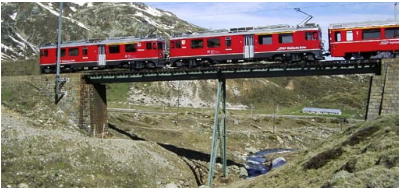
Berninastrecke > Obere Berninabachbrücke. Rhätische Bahn
