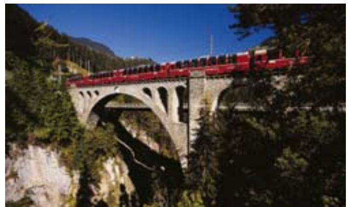
Solis > Der Solisviadukt präsentiert sich nach wie vor im Originalzustand. T. Keller
