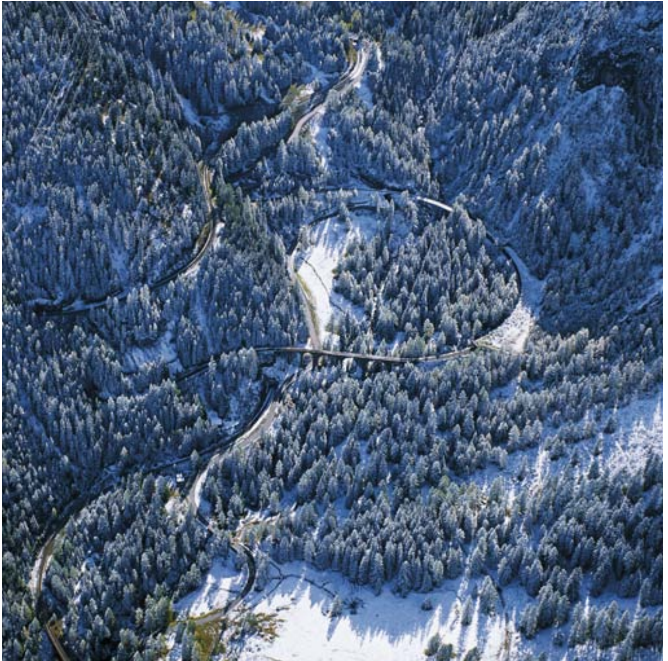
Albulastrecke > Linienführung zwischen Bergün/Bravuogn und Preda. R. Bösch / Rhätische Bahn
