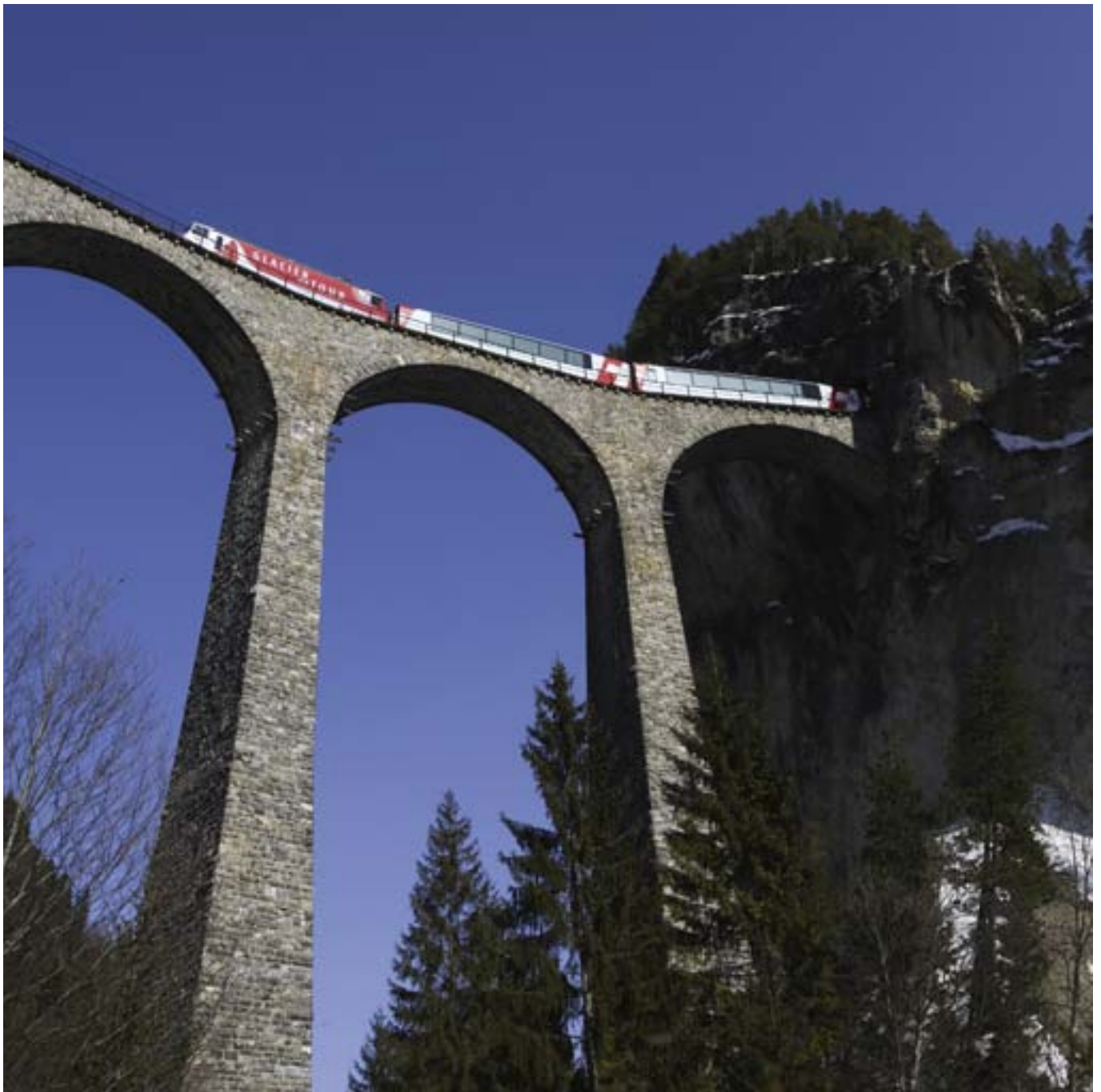
Albulastrecke > Der 65 m hohe Landwasserviadukt, der wohl spektakulärste Kunstbau zwischen Thusis und St. Moritz. A. Badrutt/Rhätische Bahn
