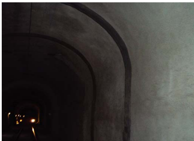
Verkleidung nach Erneuerung
